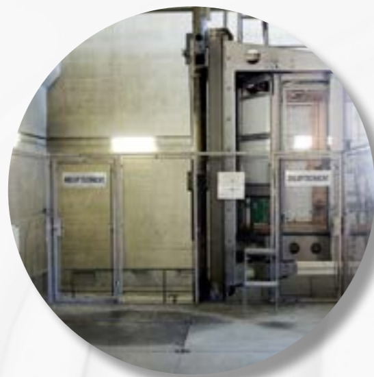
1. Der Zugang zur Schachtbefahrungsanlage am Pfändertunnel.
