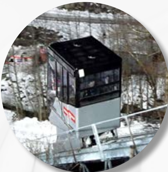
1. Die Kabine des Schrägaufzugs der Erdinger Arena mit Richtantenne.
