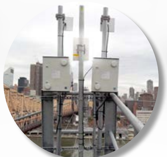
2. Der DATAEAGLE Classic 3702A im Schaltschrank an einer der beiden Kabinen.
