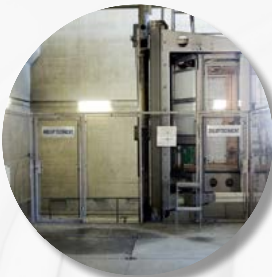
1. Der Zugang zur Schachtbefahrungsanlage am Pfändertunnel.
